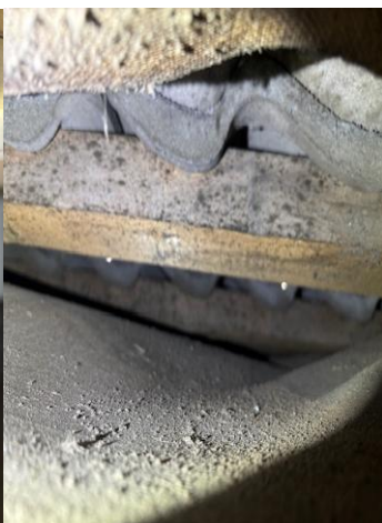
Yttertak innefrån vinden
