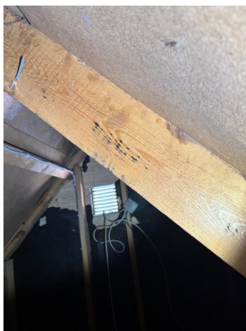
Antydning till svartmögel, vind
