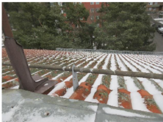
Yttertak från ca 1996
