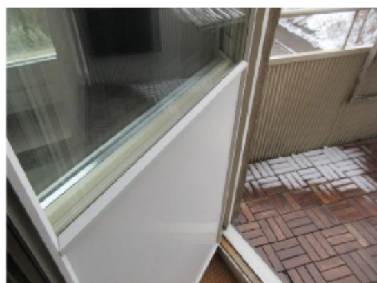
Utbytta fönster och balkongdörrar
