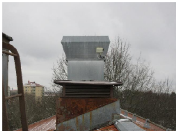
Tak med rostig plåtbeslagning
