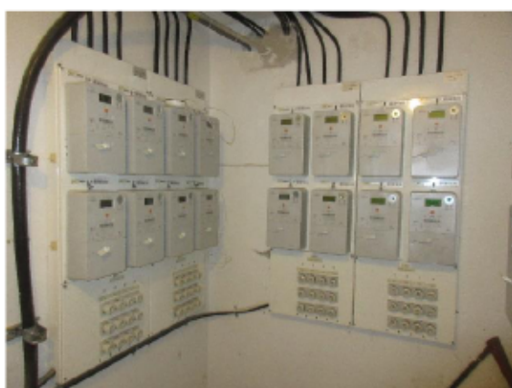
Moderniserade elektriska installationer
