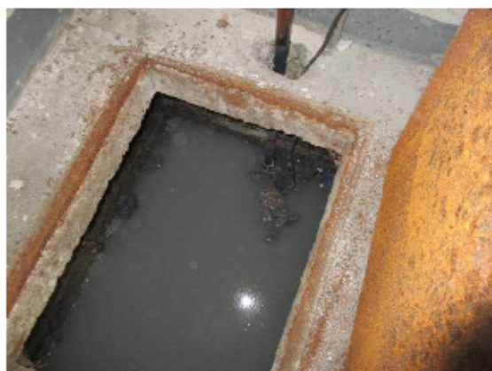
Pumpgrop gör avlopp i källarplan
