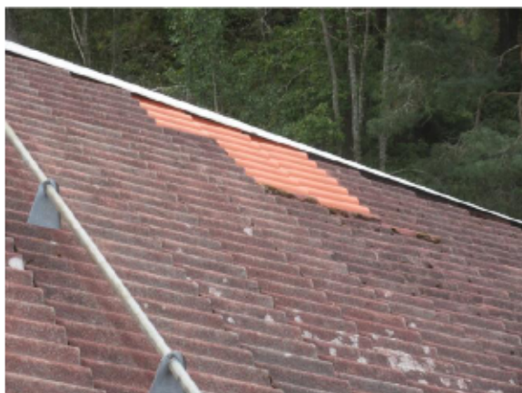
Yttertak som nyligen bättrats
