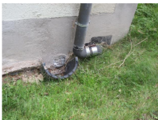
Ventilationsgaller i marknivå
